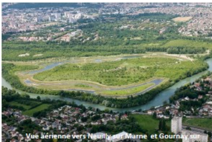
Figure 7 : Vue aérienne du parc de la Haute Ile
