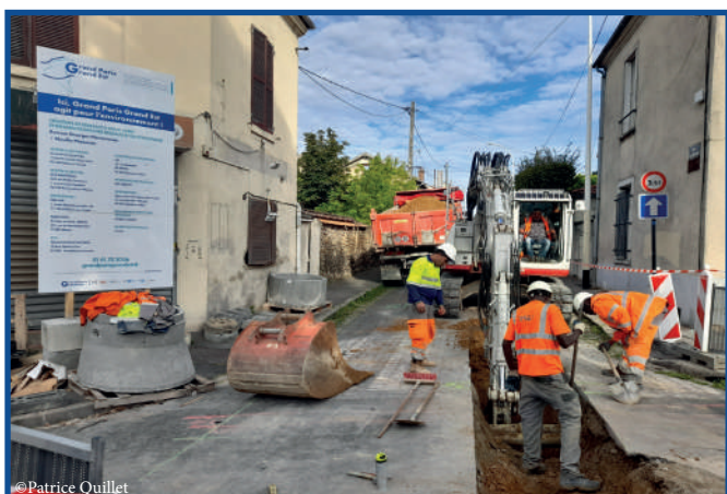
Une priorité pour GPGE : améliorer le réseau d'assainissement pour préserver les milieux naturels des rejets d'eaux pollués. Un chantier de création et de réhabilitation de réseaux d'eaux usées et d'eaux pluviales à Neuilly-Plaisance, avril 2021.
